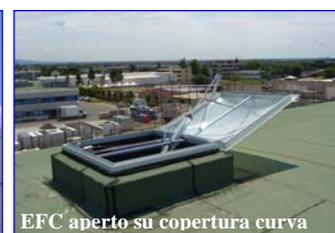
La Superficie Utile di Apertura  $A_a$  (SUA) è misurata in  $m^2$  e permette di valutare l'efficienza degli EFC nell'espellere il fumo ed il calore all'esterno.
