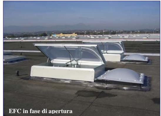
b) Con l'evacuatore sottoposto ad un carico statico di 1200 N/m<sup>2</sup>, applicato in depressione sulla superficie geometrica d'apertura interna, si è verificata la sua stabilità per un tempo di 5 minuti.
