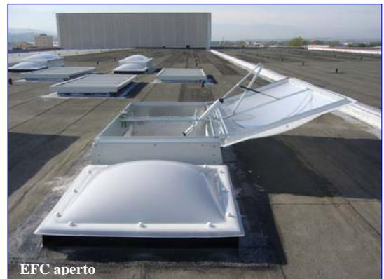
c) Con L'evacuatore sottoposto ad un carico statico di 1200 N/m<sup>2</sup>, applicato parallelamente al piano di appoggio e riferito alla massima sezione esposta, si è verificata la sua stabilità nella posizione di massima apertura e a bloccaggio avvenuto, per un tempo di 5 minuti.
