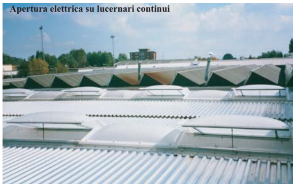
Apertura elettrica su lucernari continui
