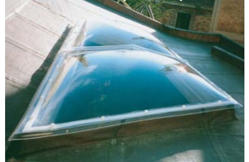
Lucernario componibile su apertura trapezoidale e copertura curva
