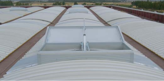
EFC aperto su copertura curva in lamiera grecata
